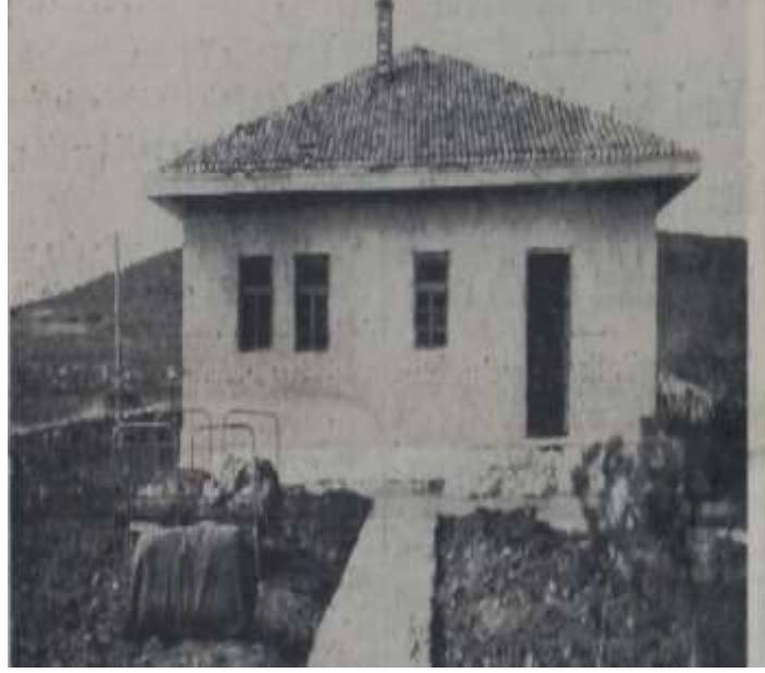
RESİM-6 Deprem Sonrası Çatlaklar Oluşan ve Boşaltılan Sofular Jandarma Karakolu ( Cumhuriyet , 27.04.1938)
